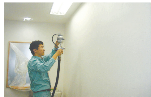
エアブラシで住宅などの壁と天井に噴霧します
