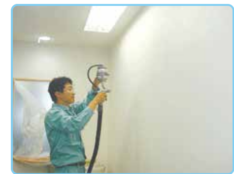
エアブラシで住宅などの壁と天井に噴霧します
